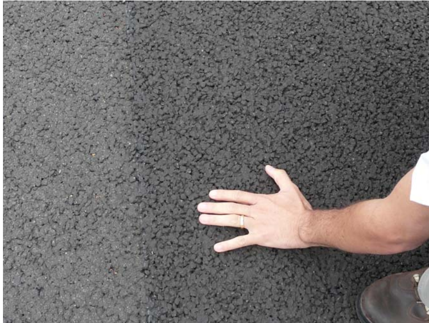
foto 9 – Detalhe da textura do revestimento do pavimento executado
