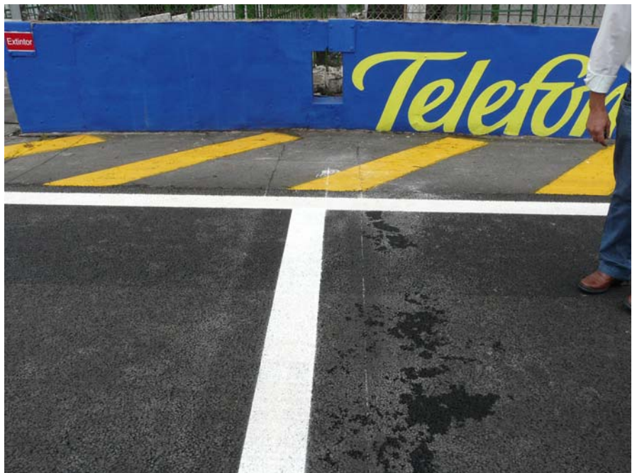
foto 8 – Detalhe das faixas de sinalização executadas no pavimento
